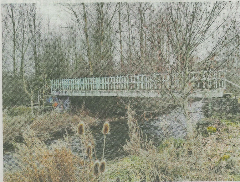
Antes de ejecutar los trabajos será necesario desbrozar parte de la ribera del río.
