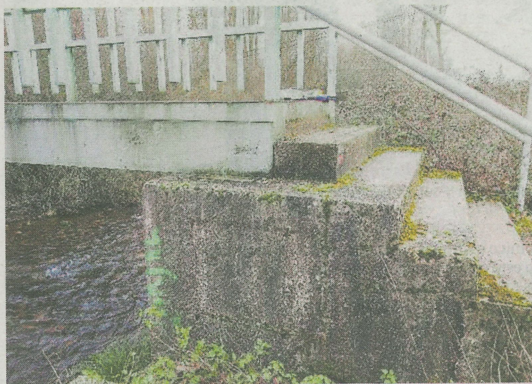
Los actuales escalones se demolerán. / FOTOS: DB
